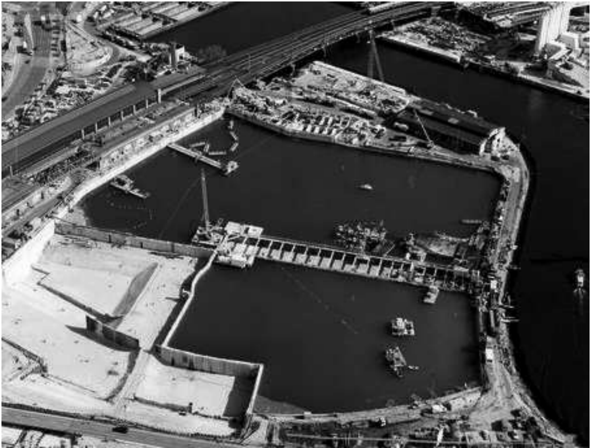
Abb. 4: Mit CO 2 betriebene Baustellenneutralisation am Berliner Hauptbahnhof, vorher Lehrter Bahnhof.
