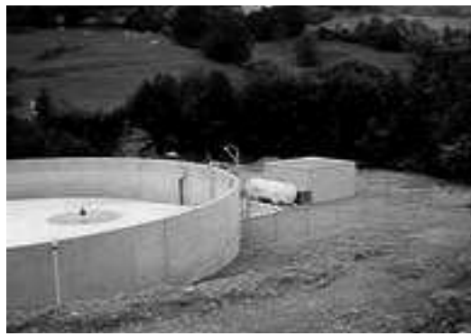
Abb. 6: Von Messer eingesetzte Neutralisationskomponenten: Begasungsschläuche (links), Stapelbecken kundenseitig erstellt (Mitte), Flüssigeinspeisung (rechts)
