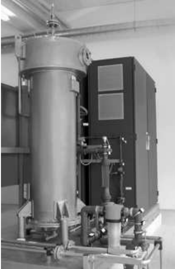
Abb. 10: Moderne Ozongeneratoren wie diese 3-kg-Anlage nutzen reinen Sauerstoff als Ausgangsprodukt
