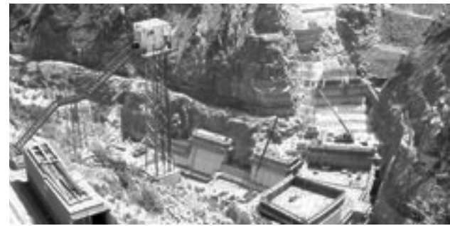
Einsatz von Betonkühlung im großen Maßstab
