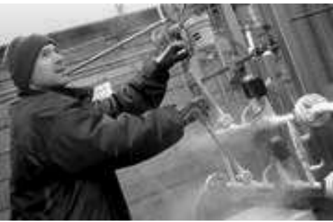
Einstellen einer Zementkühlungsanlage
