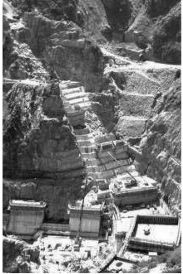
Großbaustelle Tsankov Kamak Hydro Power Plant, Bulgarien
